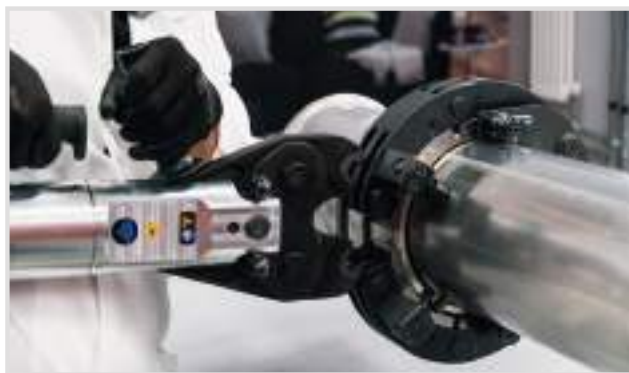
Assemblaggio pressatura n°1 / Press assembly phase 1
